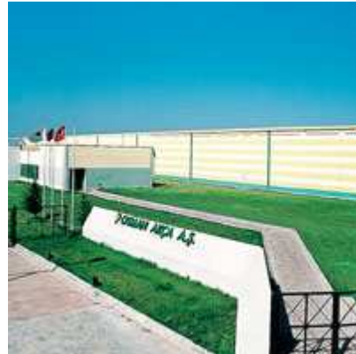
Instalaciones de O. Akça / Manisa
