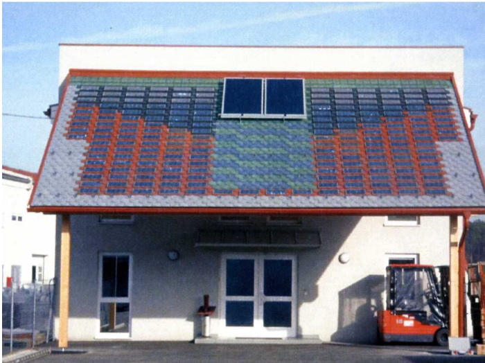
ACOPERIS CU TIGLA FOTOVOLTAICA DE TIP Pfanne
