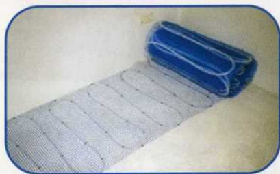
1. La malla con el serpentín se desenrolla sobre el mortero limpio e imprimado.
