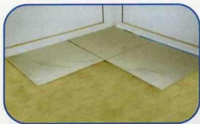
4. Colocar las baldosas sobre el suelo nivelado, de forma flexible. El relleno de las juntas se realiza asimismo de forma flexible.
