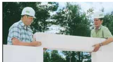
Colocando un dintel
