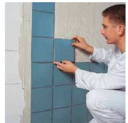
Se puede pegar azulejos directamente en la superficie de los bloques
