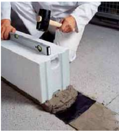
Nivelando la primera hilada
