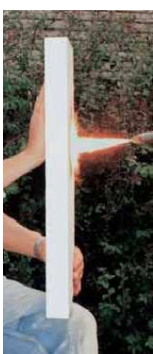
Nivelando bloques de hormigón celular
