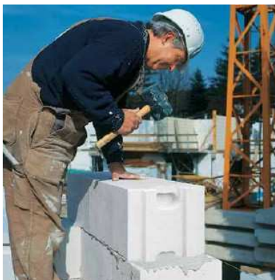
Nivelando bloques de hormigón celular
