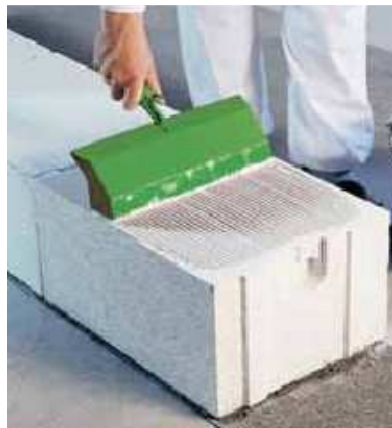
Aplicando cemento cola
